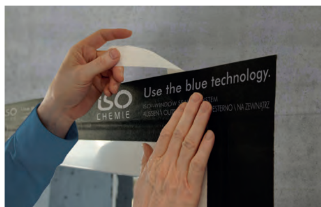
Einbaubeispiel: ISO-CONNECT OUTSIDE CL
