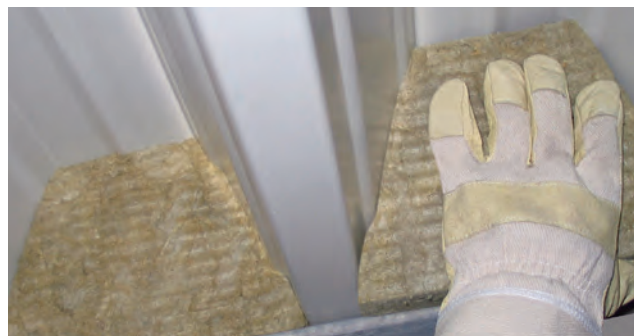
Einbaubeispiel: ISO-PROFIL FÜLLERSTÜCKE
