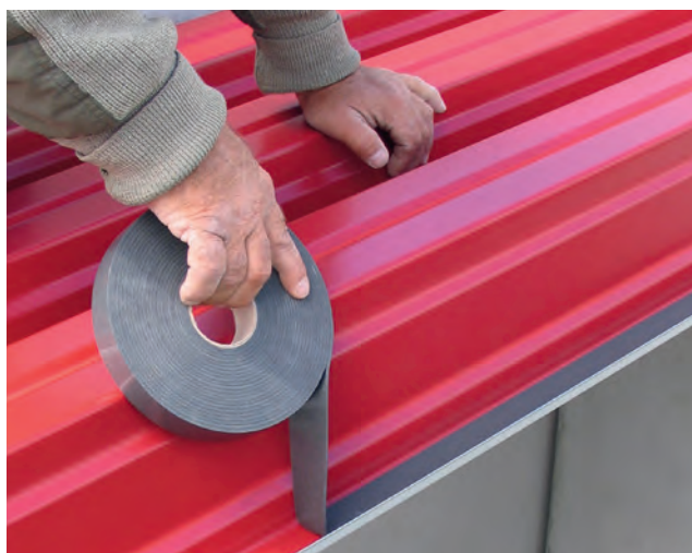
Einbaubeispiel: ISO-ZELL FIXBAND
