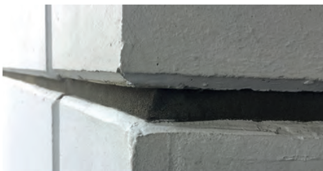
Einbaubeispiel: ISO-BLOCO AIR
