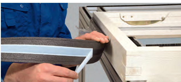
Einbaubeispiel (1-BT): Holzfenstermontage
