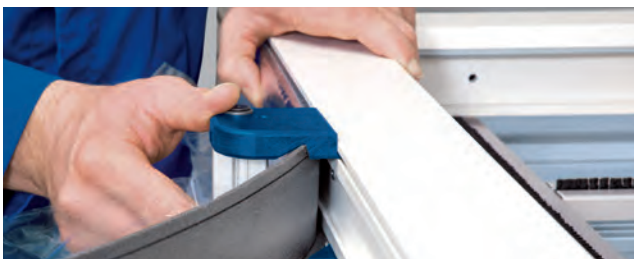
Einbaubeispiel (CB): Kunststofffenstermontage
