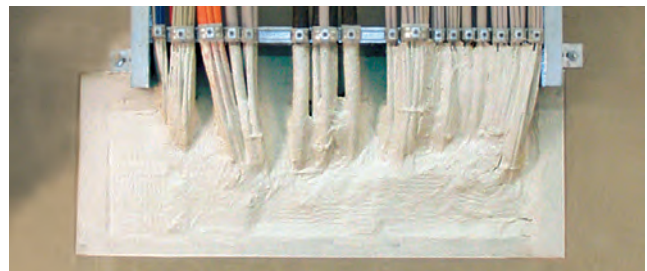
Einbaubeispiel: ISO-FLAME PLATTE S 90
