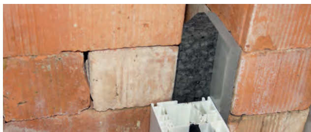
Einbaubeispiel: ISO-BLOCO FILLER
