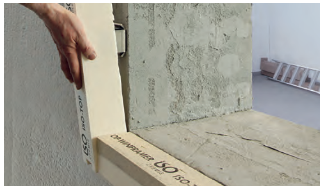
Einbaubeispiel: VORWANDMONTAGESYSTEM ISO-TOP WINFRAMER „TYP 2“
