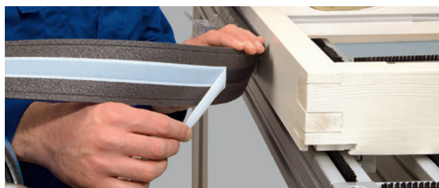
Esempio di installazione (1-BT): Montaggio su finestra in legno
