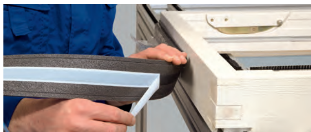
Przykład zastosowania (1-BT): montaż okien drewnianych
