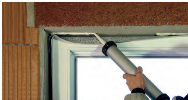
Przykład zastosowania: ISO-TOP KLEJ FLEX SP
