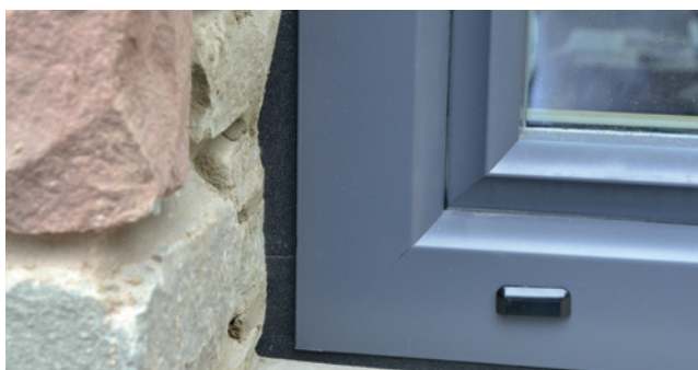
Einbaubeispiel: ISO-BLOCO AIR
