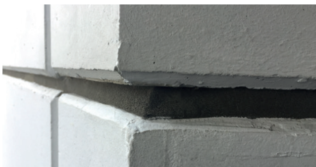
Einbaubeispiel: ISO-BLOCO AIR
