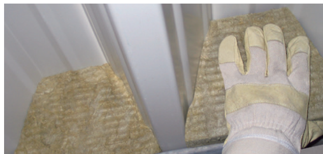
Einbaubeispiel: ISO-PROFIL FÜLLERSTÜCKE
