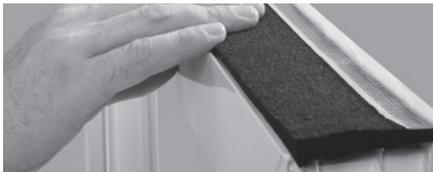
5. El tamaño de la cinta está determinado por la anchura del marco individual de la ventana. La reserva de expansión y adición en la formación de esquinas debe ser considerada según la anchura de la junta.
