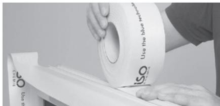
Alternativamente, la formación de la esquina con la lámina de conexión de la ventana puede hacerse de forma solapada. El solapamiento debe ser mínimo de 50 mm.
