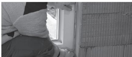
5. En la zona a revestir, aplicar el adhesivo en una superficie lo más amplia posible. Se debe dejar una superficie de lámina de 20mm que no se va a pegar como reserva de movimiento.
