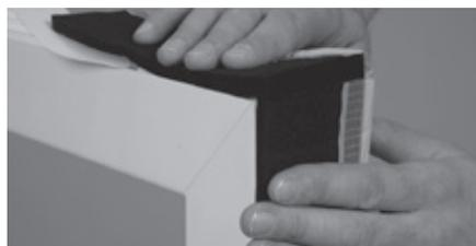
5. Bien coller également le raccord en inférieur du joint d'étanchéité sur le profil de raccord de l'appui de fenêtre. Le joint doit impérativement rester dans le périmètre du châssis de fenêtre. Dans le cas où le joint déborde de son emplacement, la mousse peut être entaillée.
