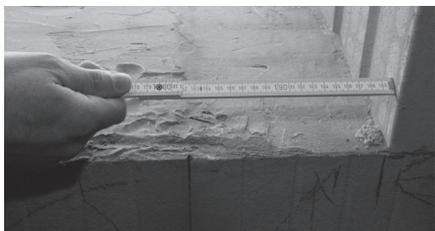
3. Mesurer la largeur de la fenêtre et la largeur de joint max. du raccord de fenêtre.
