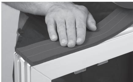
5. Calculer la longueur de la bande nécessaire à l'aide des différents côtés du châssis de fenêtre. Prévoir une réserve de dilatation et un supplément pour les angles. Pour les bandes horizontales env. 3 mm et pour les bandes verticales la largeur de l'espace à étanchéifier + 3 mm.
