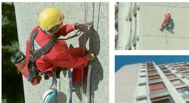
Un alpiniste industriel expérimenté a éliminé l'ancien produit d'étanchéité devenu perméable sur plus de 10 000 mètres linéaires de joints avant d'en renouveler l'étanchéité avec notre système d'étanchéité ISO-BLOCO Max 600.
