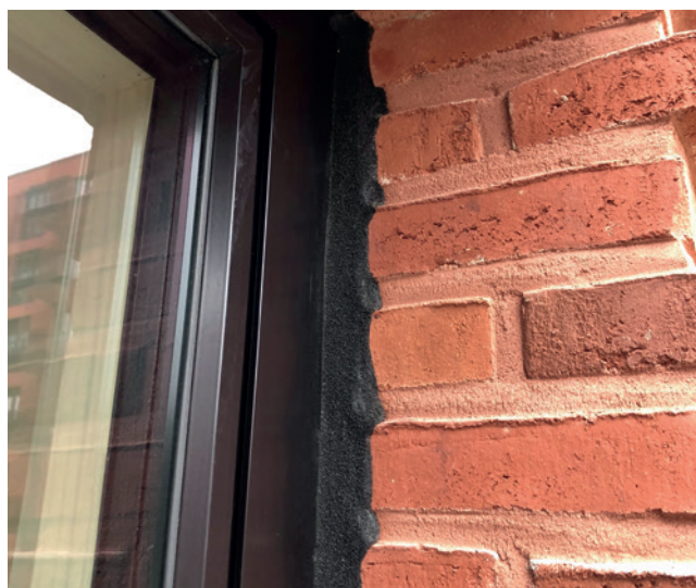
Installation example: ISO-BLOCO 600 „MAXIBOND“
